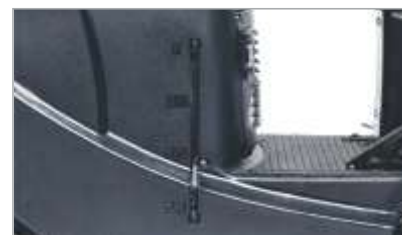
Indicador de nível de volume de água visível.
